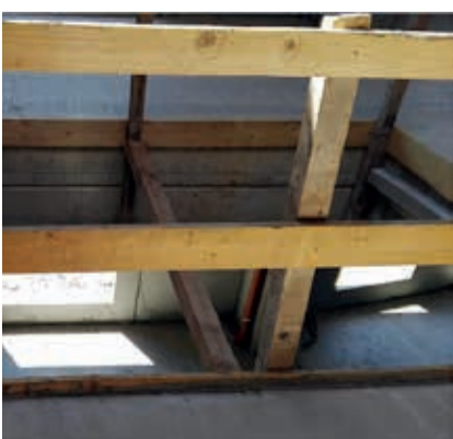
PRIMO PIANO - VISTA SU INGRESSO DEL PIANO TERRA
