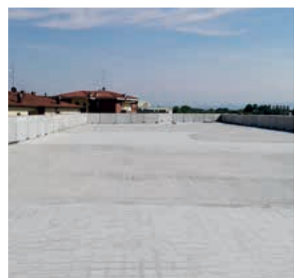
TETTO DI COPERTURA
