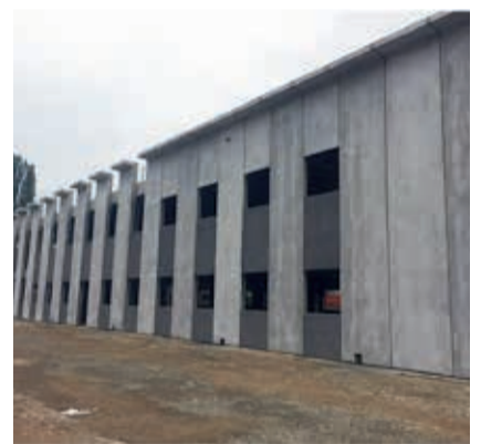
POSA DELLA STRUTTURA PREFABBRICATA
