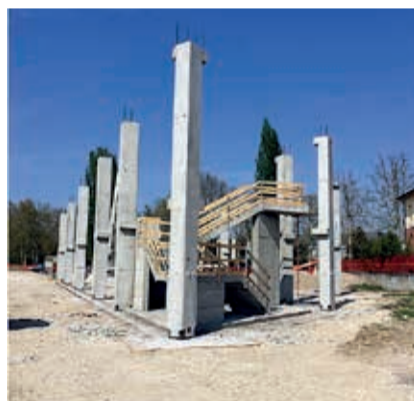
COSTRUZIONE DELLE PARTI IN CEMENTO ARMATO
