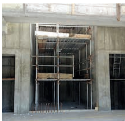
PIANO TERRA INGRESSO
