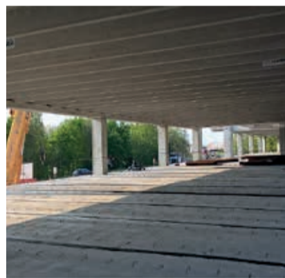
POSA DELLA STRUTTURA
