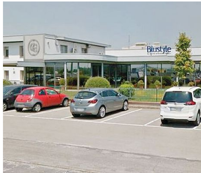
L'ingresso del magazzino della Panaria dove sono intervenuti i pompieri
